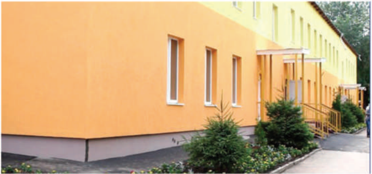
ЖДНЗ 63 після утеплення
