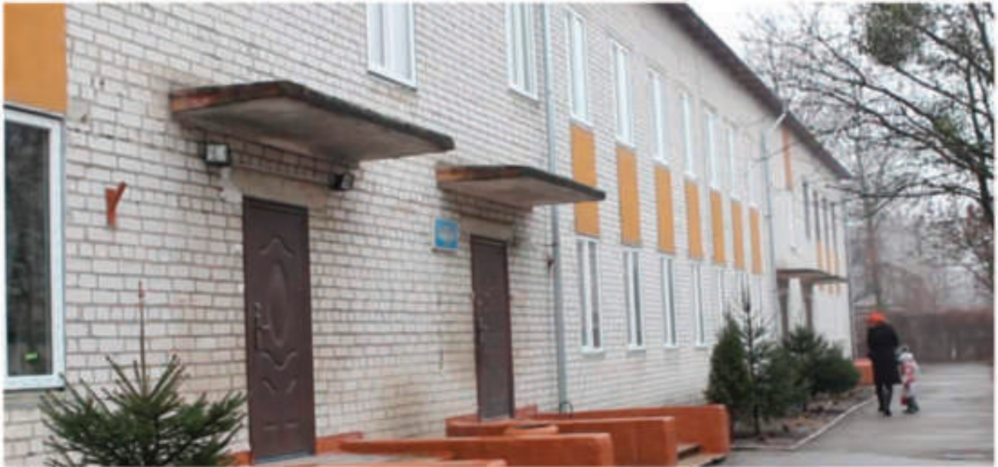
ЖДНЗ 63 до утеплення
