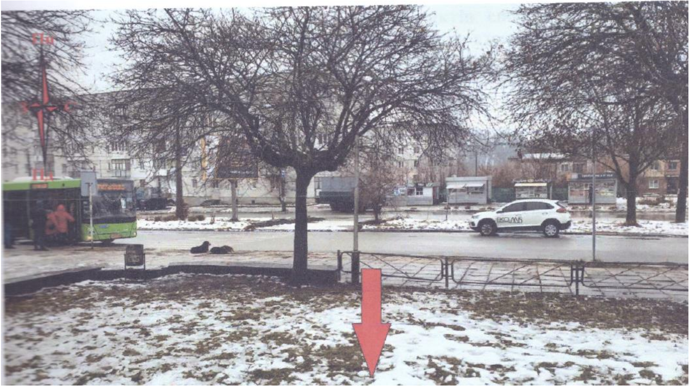
Фото 23. Вигляд із західної сторони
