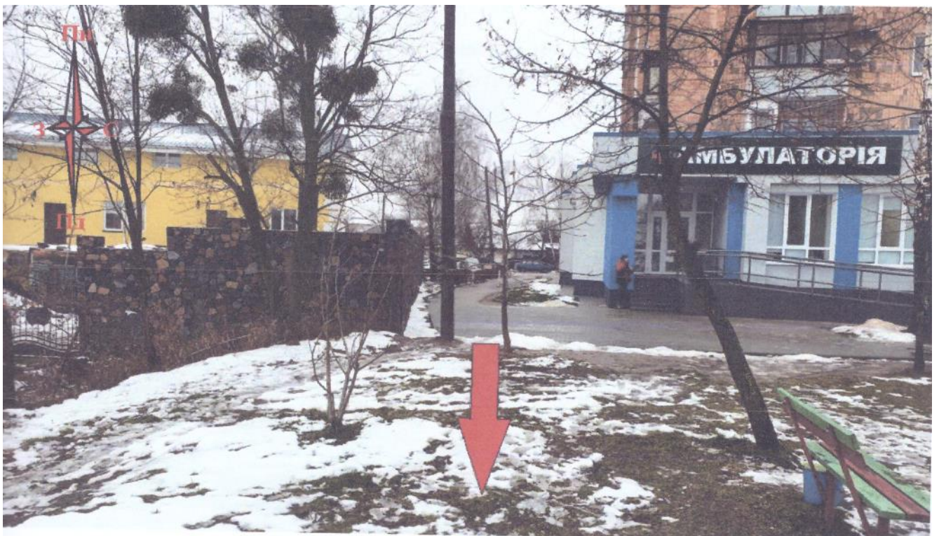
Фото 3. Вигляд із західної сторони
